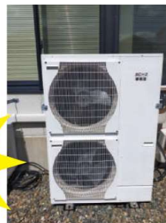
節電プラン施工
